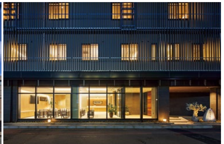
西洞院通り側低層部夜景
