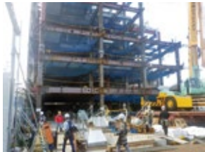
鉄骨組立状況
